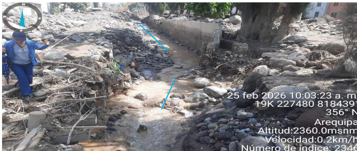
IMAGEN 02: SE OBSERVA EL CAUCE DE LA QUEBRADA CHULLO HA DESTRUIDO UNA PARTE DEL CONCRETO EN LA MARGEN DERECHA, QUE PERTENECE AL DISTRITO DE YANAHUARA CON EL PUENTE RÚSTICO ARRAYANES, DE LA QUEBRADA CHULLO, Y EN SU CAUCE SE ENCUENTRA COLMATADO.
